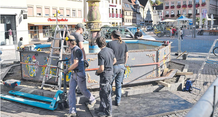
Im Herzen der Stauferstadt hat am Montag die Demontage und Restaurierung des Marienbrunnens begonnen. Foto: hs
